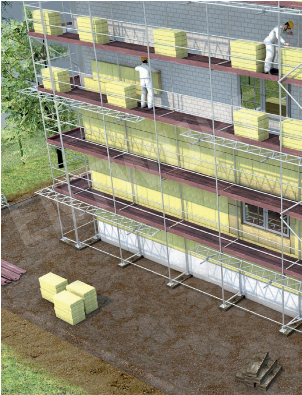
Bild 10: Beispiel für konstruktive Maßnahmen
